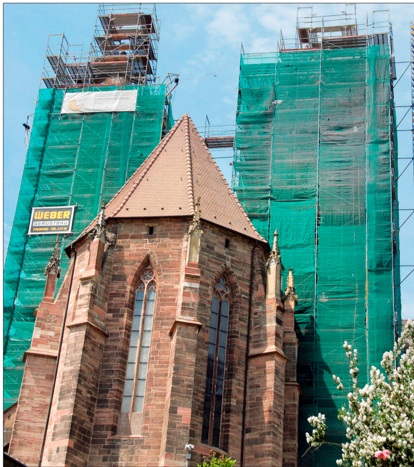
Noch sind die Türme eingerüstet. Die Renovierungsarbeiten am Breisacher Münster gehen jedoch dem Ende zu.
